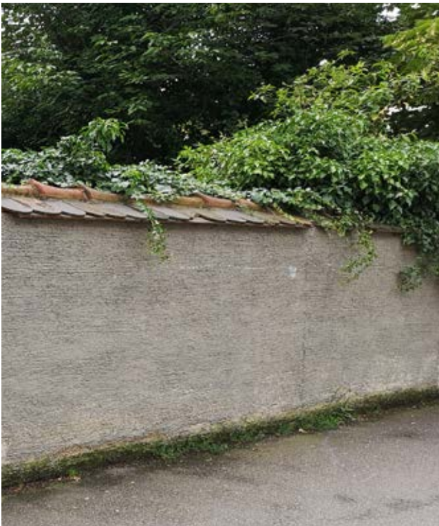
Links: Gemauerte Einfriedung mit einer Abdeckung aus Dachziegeln.
