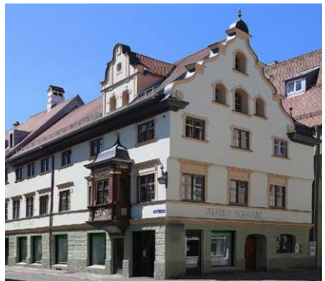
Baumstraße 1, nach der Sanierung, A. Schwarz, 2016
