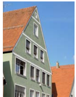
Mit angeputzten Ziegeln
