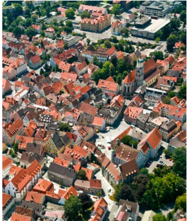
Dachlandschaft des Altstadt Ensembles, 2016, S. Kerscher
