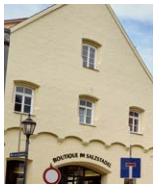
Mit angeputzten Ziegeln
