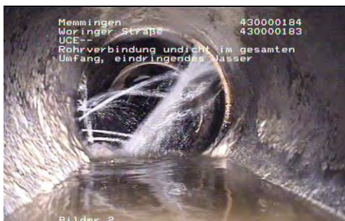
Bildnr. 2 Vor der Sanierung
