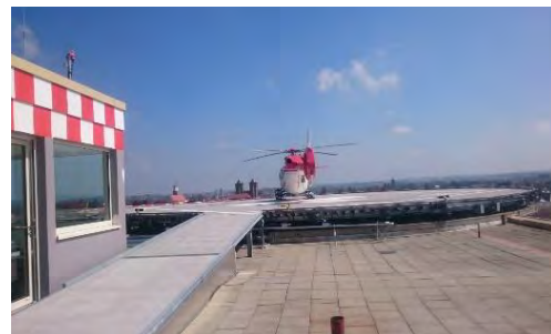
Der erste Hubschrauber auf dem sanierten Hubschrauberlandeplatz – Foto: Schopf
