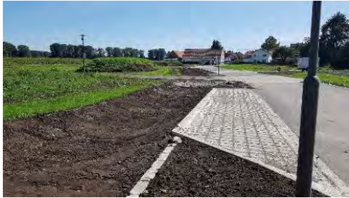
Straßenbau Schulstraße Süd Steinheim
