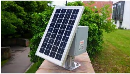
Stadtmauer Geomonitring Gateway Solar
