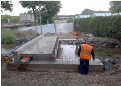
Münchner Straße, Neubau Brücke, Mai 2018
