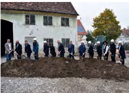
10.10.2018: Den offiziellen Spatenstich zum Start der Sanierungsmaßnahmen am Zehntstadel in Steinheim eröffnet Oberbürgermeister Manfred Schilder mit den Worten: „Was lange währt, wird endlich gut“. Das denkmalgeschützte Gebäude aus dem späten Mittelalter soll bis zum Frühjahr 2020 in ein Dorfgemeinschaftshaus umgebaut werden.
