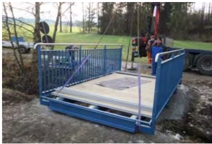
Brücke Weiherstraße, Dezember 2018
