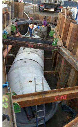
Verlegung des neuen Stauraumkanals DN 1800 aus Stahlbeton im Spundkastenverbau mit Gurten und Ausstrebungen
