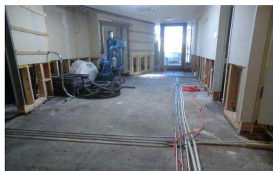
9. Wasserschadensanierung der im Jahr 2015 neu gebauten Gemeinschaftsunterkunft für Asylbewerber in der Kühlhausgasse. Vollständiger Rückbau des Innenausbaus einschließlich der Installationen in zwei Bauabschnitten. Die Bewohner wurden teilweise ausquartiert. Beginn der Maßnahme Oktober 2016, Fertigstellung Haus 01.02.2017, Haus 02.08.2017. Die Sanierungs-kosten werden vom Schadensverursacher getragen.
