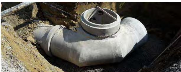
Verlegung eines 2 schnittigen Krümers, Regenwasserkanal DN 800 aus Stahlbeton
