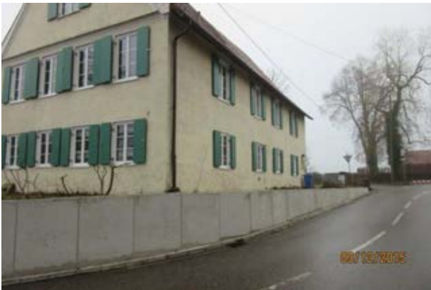
Stützmauer in Ortbeton, Oberdorfstraße Dickenreishausen
