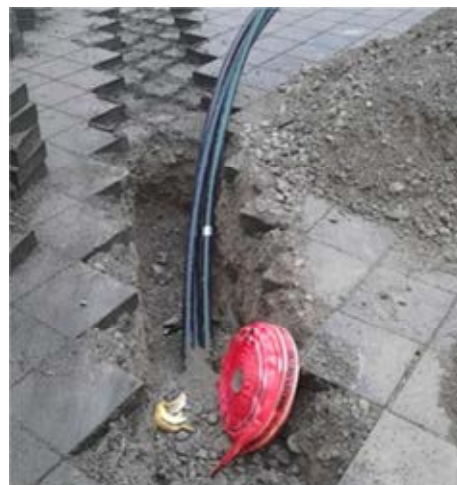
Kabelverlegung Vodafone – Kalchstraße/Hallhof
