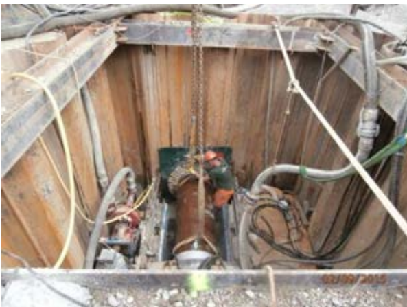
Kanalbau Oberbrühlstraße: Durchpressung Bahnübergang DN 600 Stz
