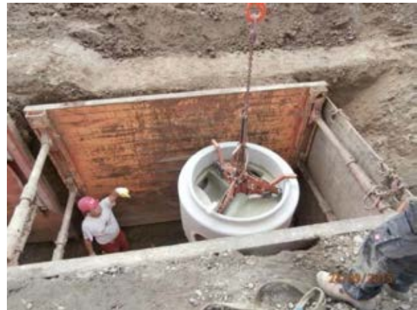
Kanalbau Steinheimer Stadtweg: Schachtunterteil mit GFK-Gerinne
