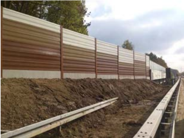
Lärmschutzwand aus Alu-Paneelen entlang der A7
