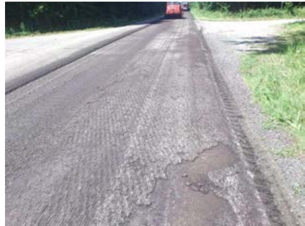
Abfräsen der alten Fahrbahndecke, MM 26
