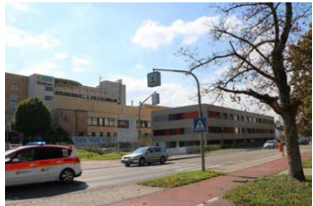
Neubau der Notfallklinik
