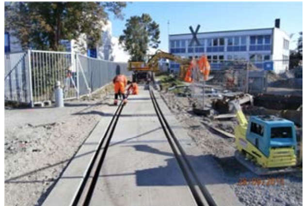
Verlegte Gleistragplatten am Bahnübergang in der Oberbrühlstraße
