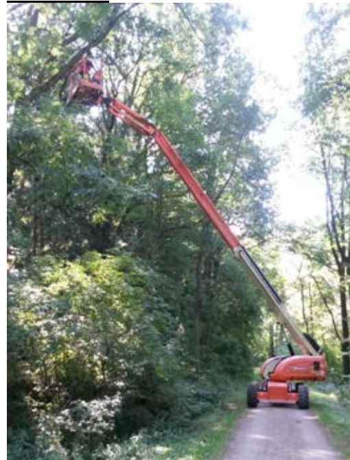
Mit der Hebebühne entfernen Forstwirte faule und tote Äste entlang des Bahnradweges
