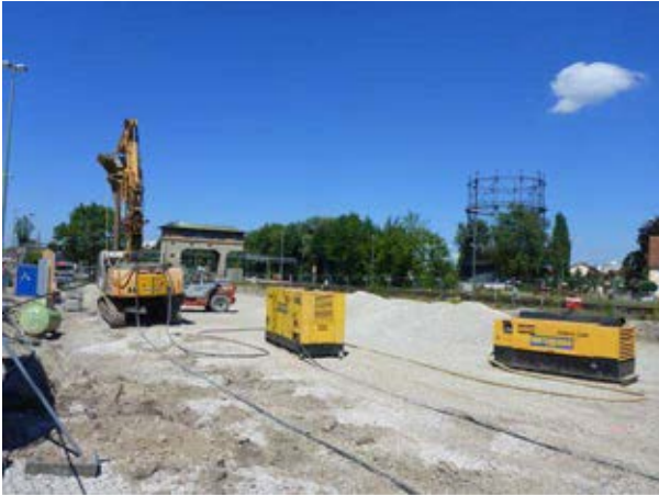
Platz 03 – Neubau Parkhaus Stadtwerke MM, MN2108 [im Auftrag Fa. Goldbeck Süd GmbH]
