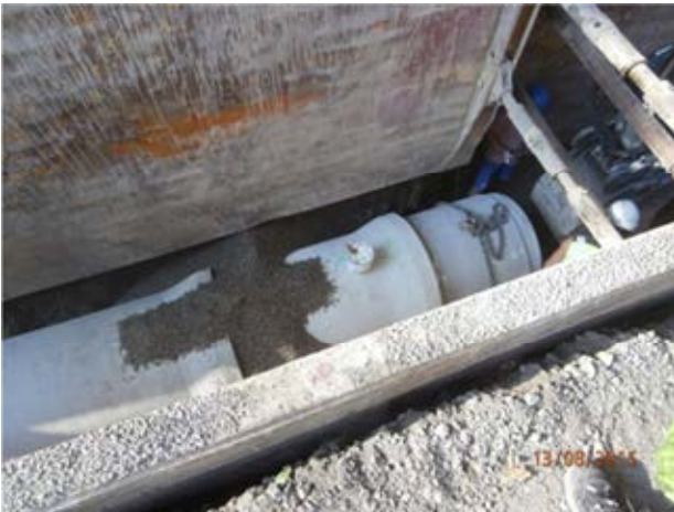
Kanalbau Reichshain, Verlegung DN 800 Sb
