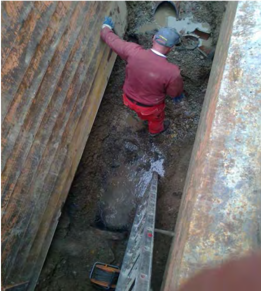
Schadensbehebung am Mischwasserkanal, Hintere Gerbergasse
