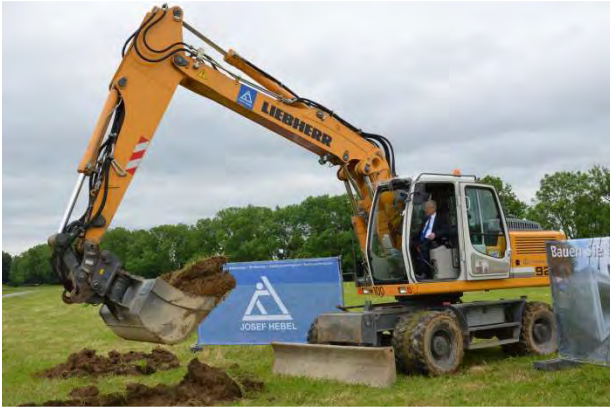
Spatenstich Baugelbiet Dobelhalde
