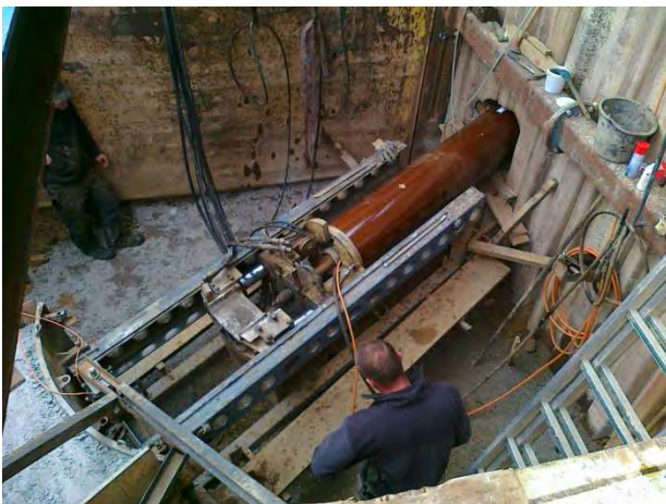
Pressgrube Kanalbau Dobelhalde
