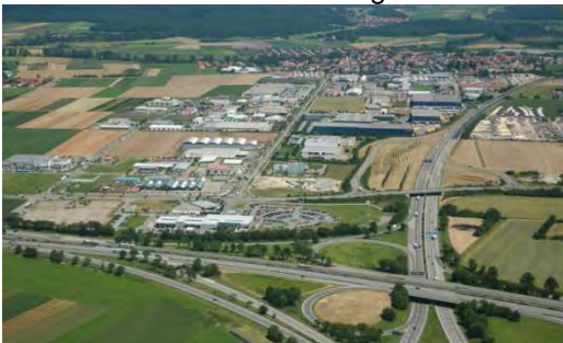
Luftbild Gewerbegebiet Nord mit Autobahnkreuz
