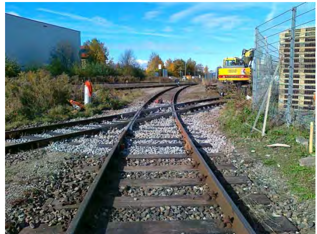
Erneuerte Gleiskreuzung südlich der Oberbrühlstraße
