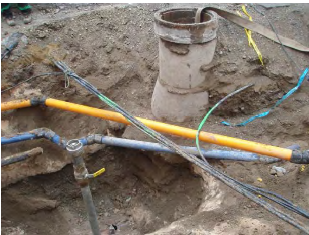
Kanalbau Furtgasse – querende Sparten
