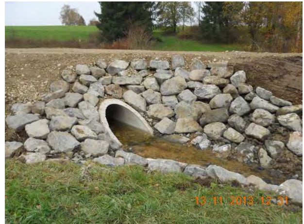
Bachdurchlass „Legauer Bahn“
