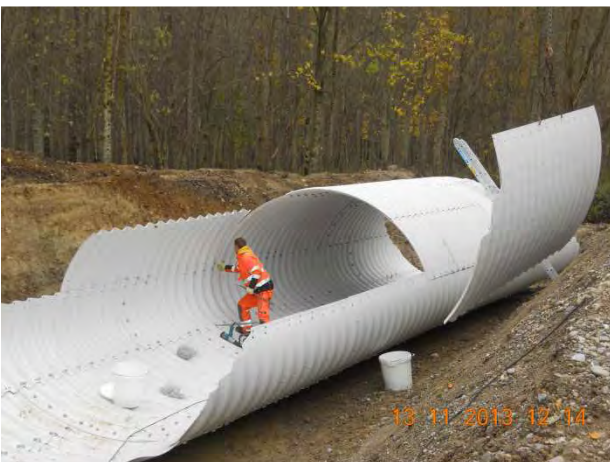
Zusammenbau des Stahlwellblechdurchlasses
